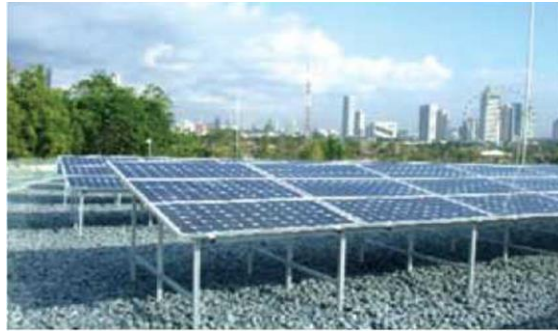
รูปที่ 40 อาร์เรย์แผงเซลล์แสงอาทิตย์ที่มากกว่าหนึ่งอาร์เรย์
