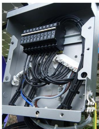
รูปที่ 70 กล่องต่อสายร่วมของแผงเซลล์แสงอาทิตย์ขนาด 4 กิโลวัตต์ รวม 10 แผง เพื่อป้องกันสายเคเบิลเดี่ยวไปยังตัวควบคุมการชาร์จ
