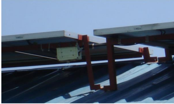
รูปที่ 146 การป้องกันกล่องต่อสายจากฝน
