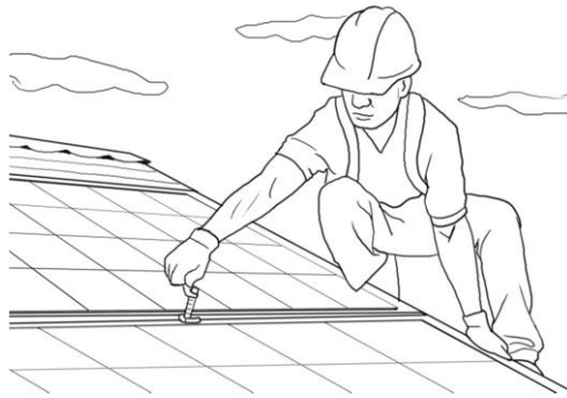
รูปที่ 183 ตรวจสอบสภาพของโครงสร้างการติดตั้งอาร์เรย์
