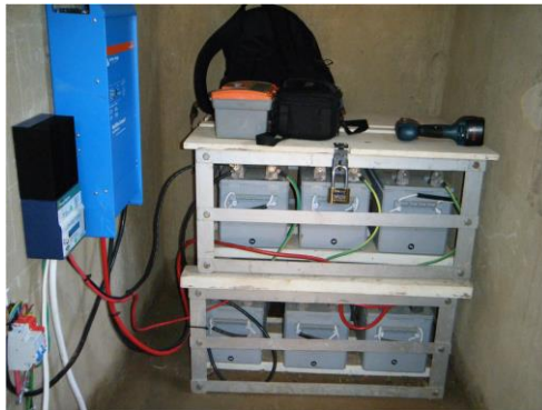
รูปที่ 104 แบตเตอรี่ที่ได้รับการป้องกันในช่องใส่แบตเตอรี่
