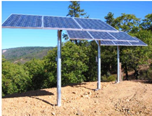
รูปที่ 96 แผงเซลล์แสงอาทิตย์ติดตั้งบนเสาเดี่ยว
