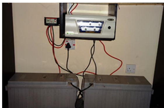
รูปที่ 99 การตัดวงจรออกจากแบตเตอรี่แบงก์ 24 โวลต์
