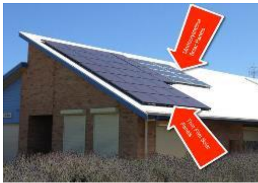
รูปที่ 25 การติดตั้งแผงเซลล์แสงอาทิตย์บนหลังคาโดยด้านซ้ายคือแผงแบบฟิล์มบางและด้านขวาคือแบบโมโนคริสตัลไลน์
