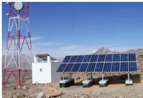
รูปที่ 80 ระบบเซลล์แสงอาทิตย์ที่ใช้สำหรับโหลดไฟฟ้า AC ของเสาโทรคมนาคม
